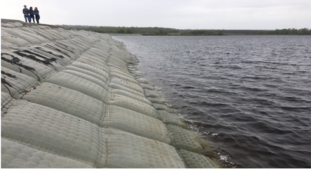
Рис. 1. Фотография крепления откоса из БНТМ в форме «бетонных плит»
